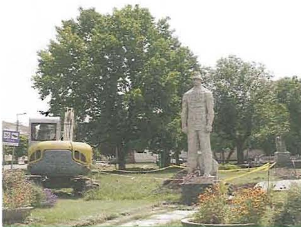
Megezdődött az endrői Hősök tere átépítése
