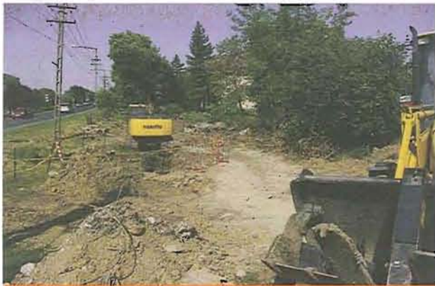
A „Belvív 9. ütem” elnevezésű 243,5 milliós beruházás kivitelezési munkálatai már elkezdődtek
