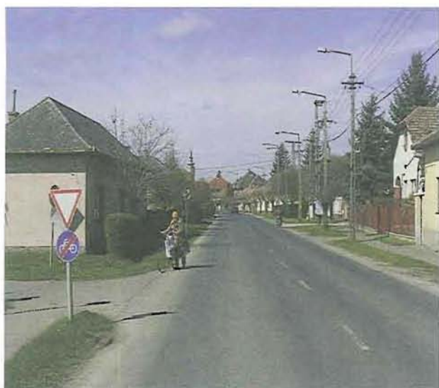
Innen, a Kodály utcától folytatják a bicikliút építését
