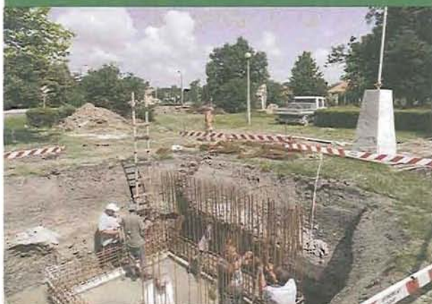
A szökőkút gépészeti aknáját építik
