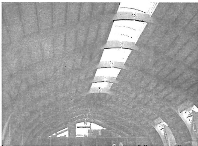
Az épülő fedett uszoda belső terében a rétegelt tartógerendák a gyomaendrői Gyefa Kft. munkája
