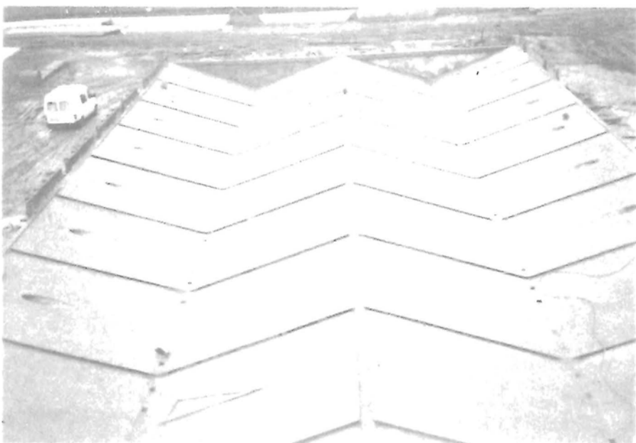
A szarvasi Pioneer 1998. évi fejlesztésében a Dambatter Kft. a siló-tároló bővítését végezte. Az 55 m hosszú, 23 m széles, 22 rekeszes, egyenként 6000 tonna tárolókapacitású tároló alapozását látjuk a képen
