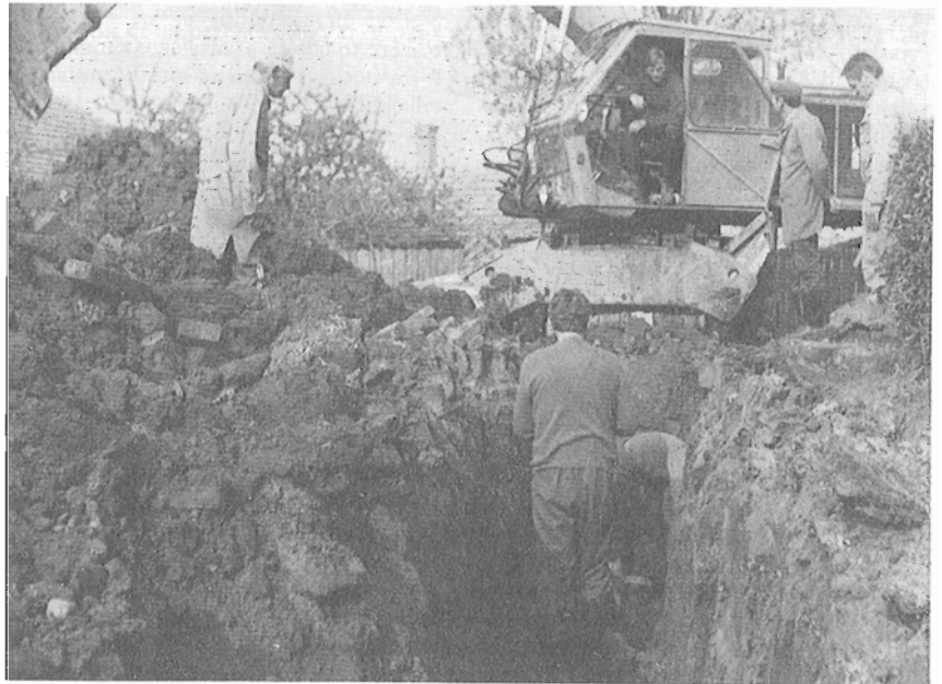
A Szabadság utcai szennyvízvezeték építése
