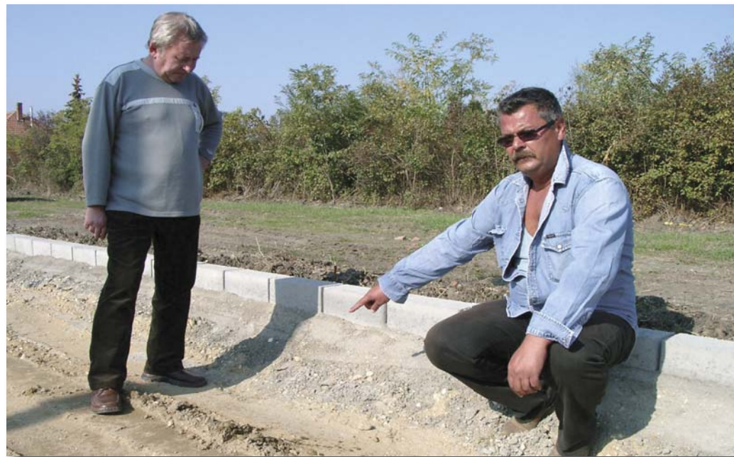
Felvételünkön jól látható, milyen mély alapot kapott az út, az aszfalt a szegélykö magasságába került. Balról Rác Imre önkormányzati képviselő, jobbról Csahóczi János.
