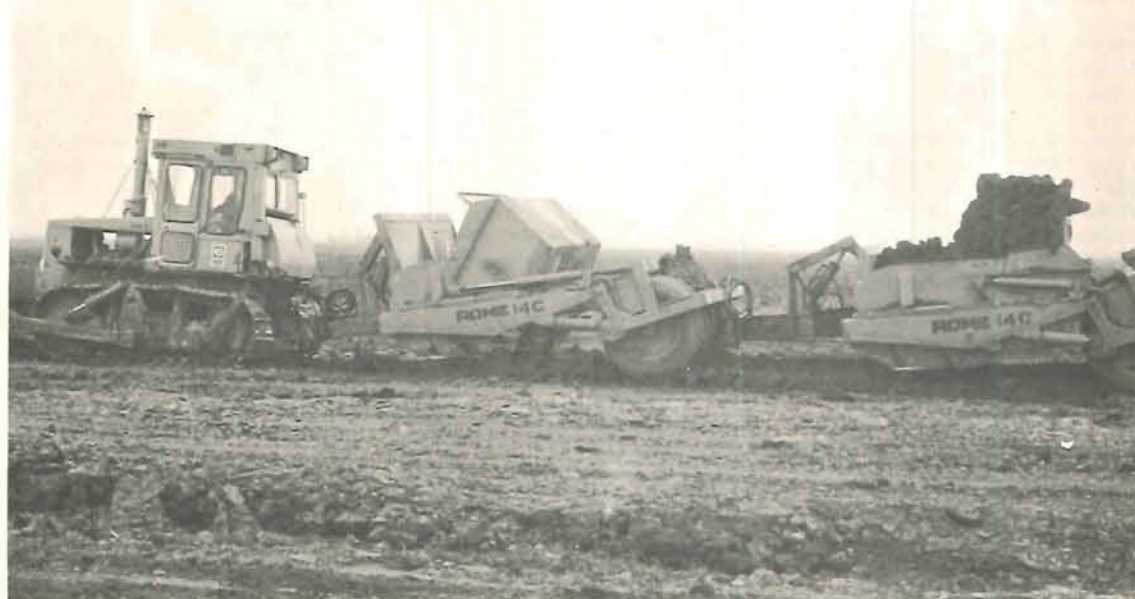
Rizstelep építése Caterpillar géppel
