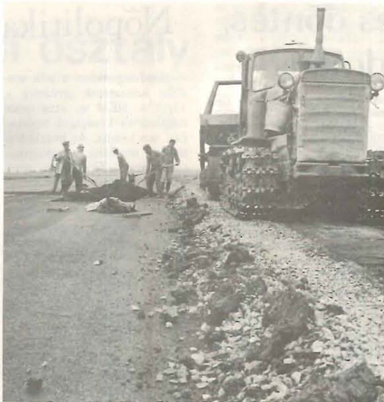
Épül a felszállópálya
