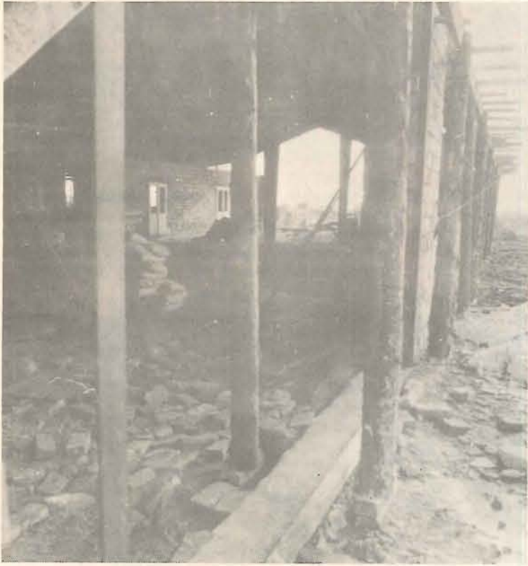
Épül a gépműhely Kőszigeten
