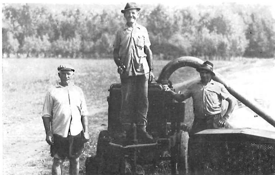
MA-200-as, kézi erővel telepíthető öntözőberendezés
