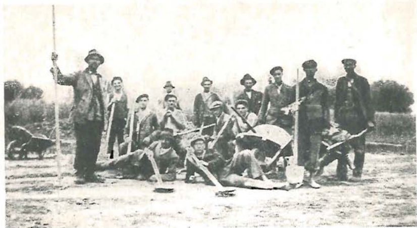
A medvei hid építésénél
