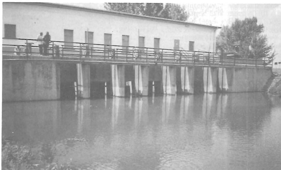
A Villogói főcsatorna szivattyútelepe
