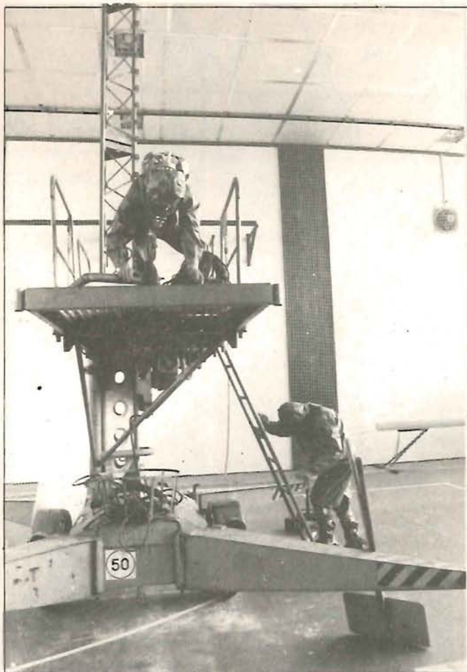
Az álmennyezet lámpanyílásait megbontva jutnak fel a tetőtérbe
