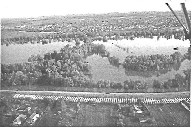
Bordás megtámasztás a jobb parton, a „cigányvárosnál”
